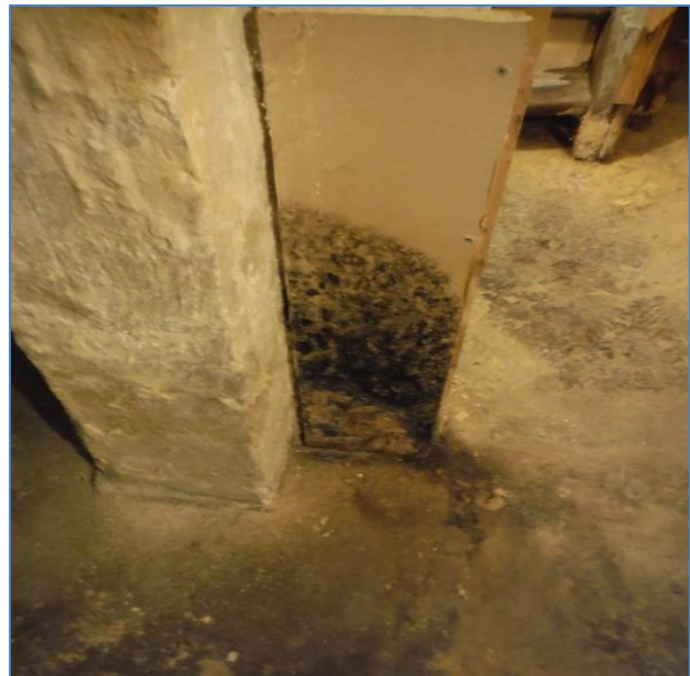
Skimmel på bløde materialer i kælder
