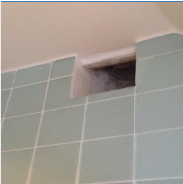
Aftræk i bad
