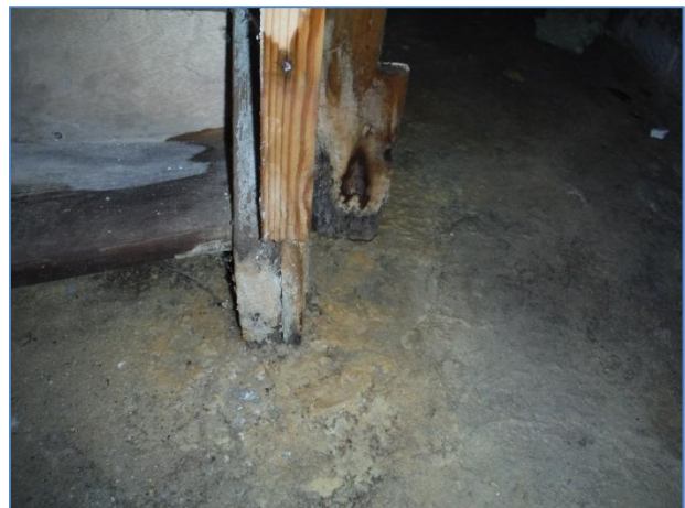
Rådskader på organiske materialer i kælder
