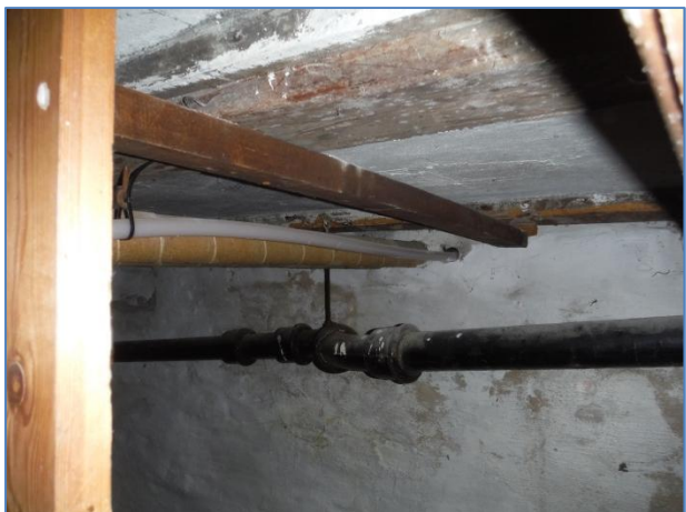
Installation i kælder
