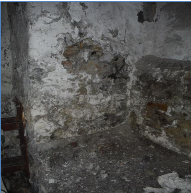
Fugtskader i kælder
