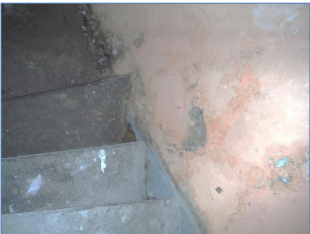
Fugtskader på kældertrappe
