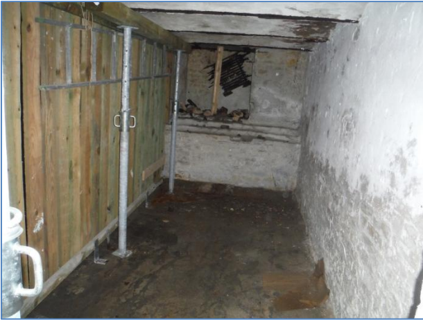
Støtte under portdæk
