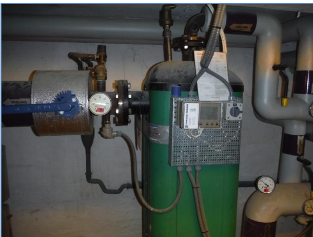
Installation i kælder
