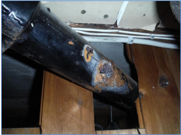
Faldstamme i kælder
