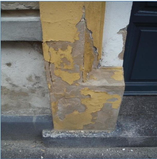
Fugtskader på facader
