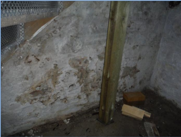
Fugtskader i kælder
