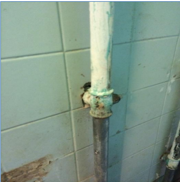
Vandrør i bolig
