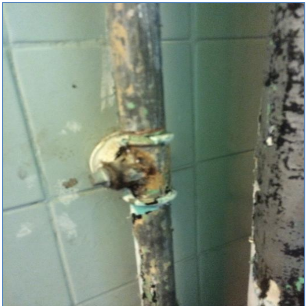
Vandrør i bolig
