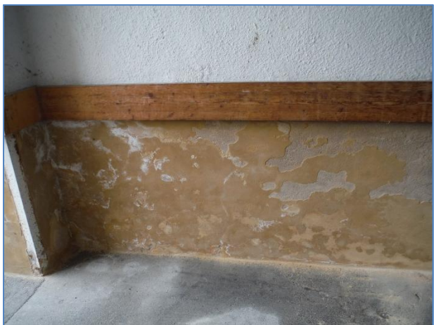
Fugtskade i portgennemgang
