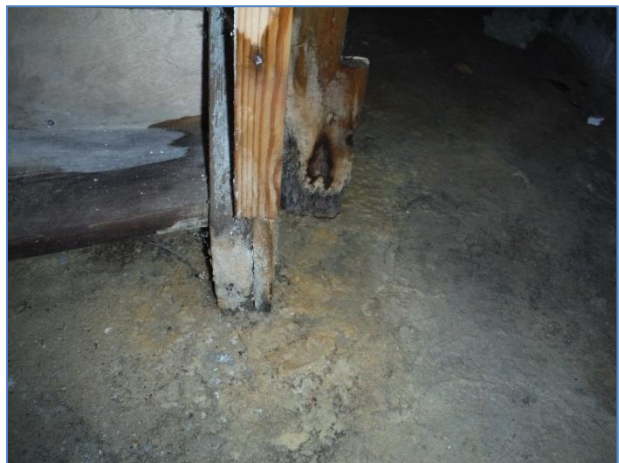
Fugtskader på kældertrappe
