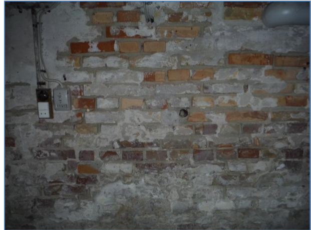
Fugtskader i kælder
