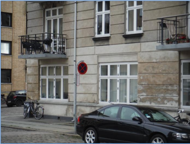
Fugtskader på facader
