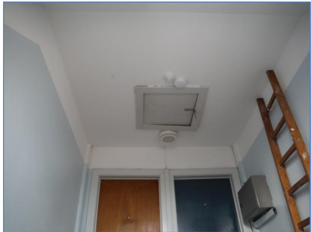
Opgang til loft
