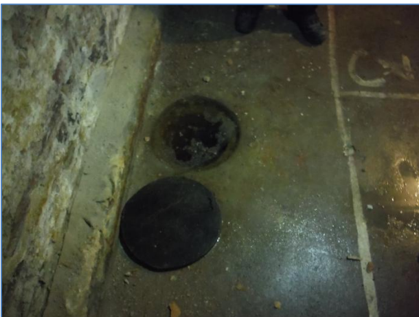
Blankt vand på kælderdek
